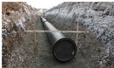
網走川中央地区(用水管敷設)
