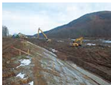
常呂川の河道掘削
