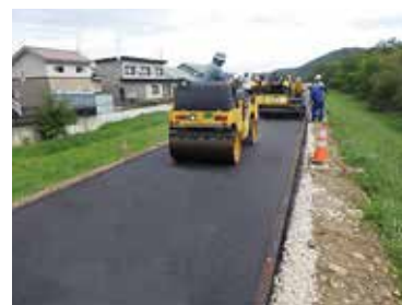
天端保護の状況
