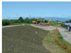
湧別川の浸透対策状況 (堤防断面拡大工法)
