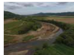
常呂川の河道掘削状況
