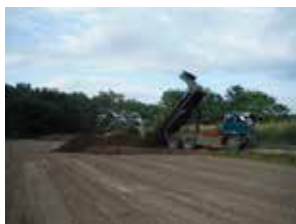
農地復旧状況
