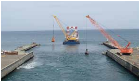
サロマ湖漁港(第2湖口工区)水深4.5m航路浚渫
