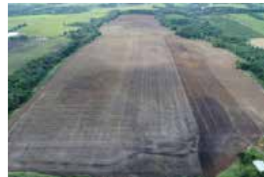
雄武丘陵地区北幌内13工区 区画整理
