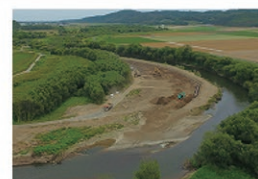
常呂川の河道掘削状況
