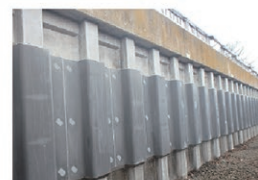
網走川特殊堤の補修完了状況
