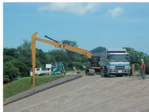
湧別川の浸透対策施工状況
