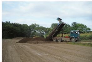
農地復旧状況
