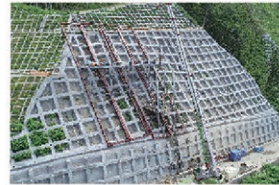
国道334号真鯉道路 (防災対策)
