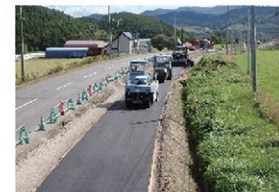
国道333号視距改良 (交通安全対策)
