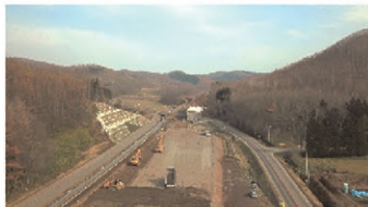
国道333号 生田原道路
