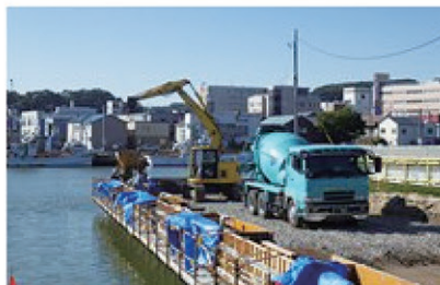
網走港川筋地区 水深3.0m物揚場改良
