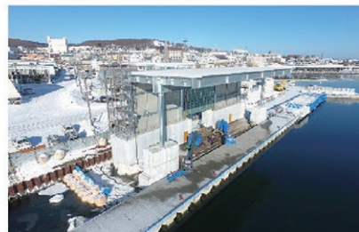
紋別港港町地区 水深4.0m西物揚場改良
