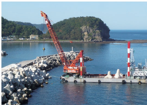
ウトロ漁港(ウトロ工区)西防波堤(改良)
