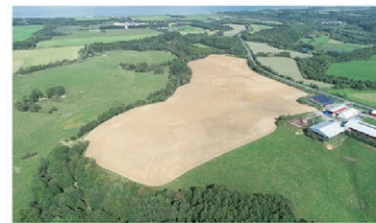
雄武丘陵地区北幌内工区 区画整理
