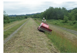
堤防除草状況（湧別川）
