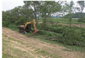
樹木伐採状況 (網走川水系美幌川)
