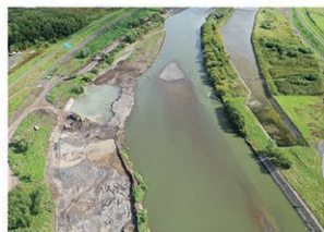
河道掘削状況（渚滑川）
