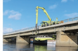
国道238号 橋梁点検
