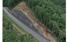
国道243号 道路斜面对策
