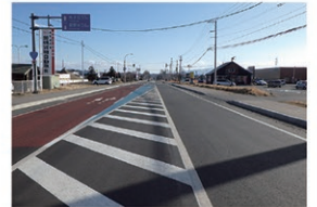
国道243号 交通安全対策
