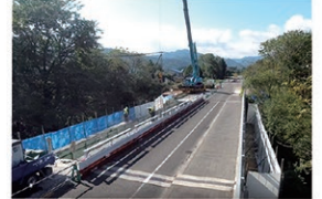
国道273号 橋梁老朽化対策
