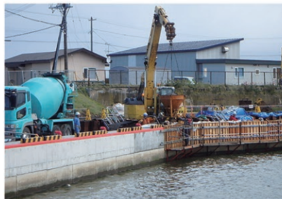
網走港川筋地区 水深3.0m物揚場改良
