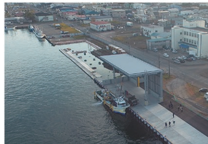
紋別港港町地区 水深4.0m西物揚場改良
