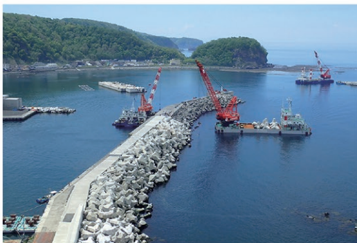
ウトロ漁港(ウトロ地区)西防波堤(改良)
