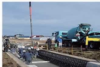
網走川中央地区西幹線用水路
