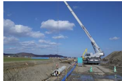
兵村地区第2幹線排水路
