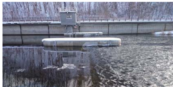
網走川大曲堰(鋼製起伏ゲート起立中)
