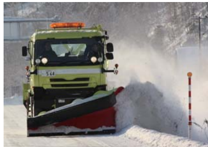
除雪作業状況
