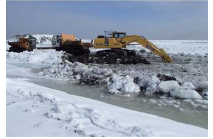
渚滑川河道掘削
