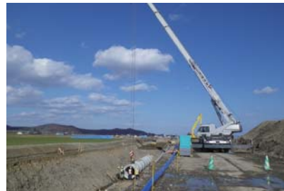
兵村地区第2幹線排水路
