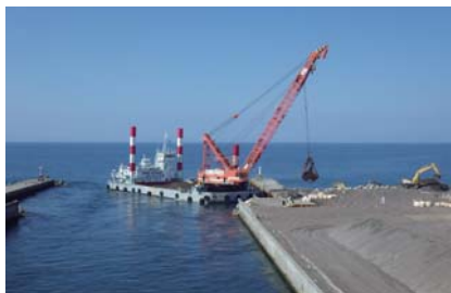
サロマ湖漁港(第2湖口工区)水深4.5m航路浚渫
