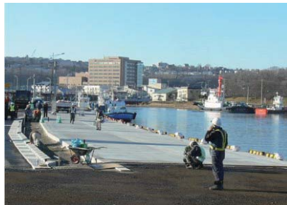
網走港川筋地区 水深2.0m物揚場改良
