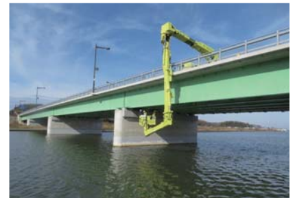
橋梁点検状況
