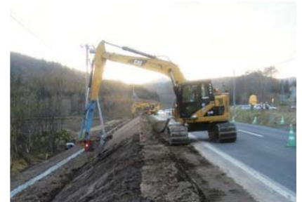
一般国道333号路肩拡幅
