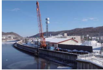
網走川特殊堤コンクリート矢板補修
