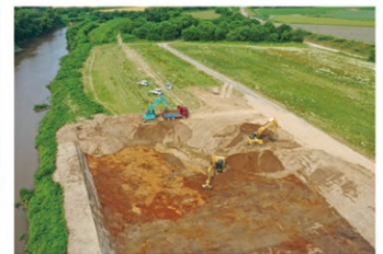
河道掘削(常呂川)
