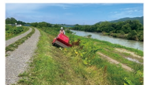
堤防除草状況(渚滑川)
