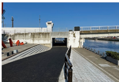
河川管理用道路整備
