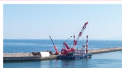
網走港新港地区 南防波堤改良
