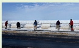
東オホーツクシーニックバイウェイ活動団体との防波堤の堆雪除雪作業(国道334号斜里ウトロ地区)
