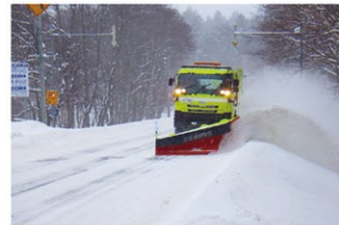
国道240号における除雪作業状況
