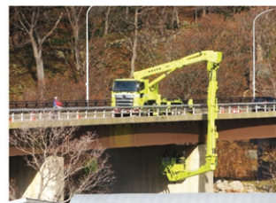
橋梁点検車による定期点検
