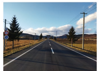
国道333号 佐呂間町路肩改良
