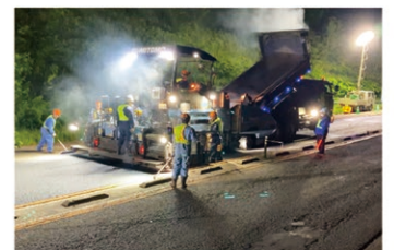
舗装の修繕状況
