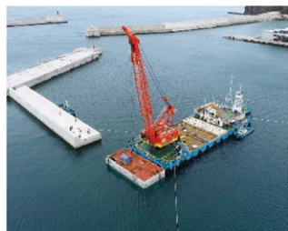
ウトロ漁港 南防波堤
