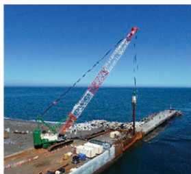
サロマ湖漁港(第2湖口地区) 西防砂堤
