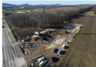
常呂川下流地区(排水機場の整備)
