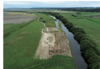
河道掘削(常呂川)
