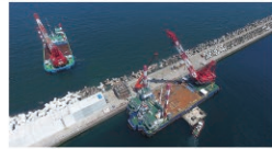
網走港新港地区 南防波堤改良
