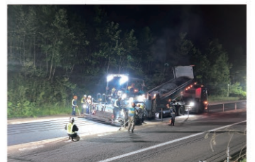
舗装の修繕状況
