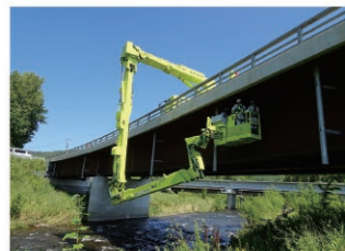
橋梁点検車による定期点検
