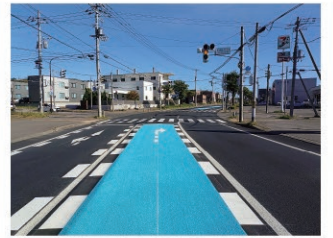
国道333号 網走市路肩改良
