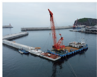
ウトロ漁港 南防波堤
