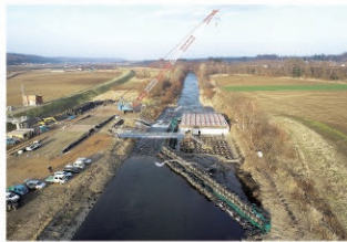
網走川中央地区(頭首工の改修)
