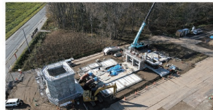
常呂川下流地区(排水機場の整備)
