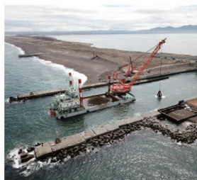
サロマ湖漁港(第2湖口地区) 水深4.5m航路(補修)
