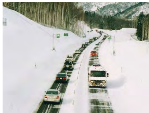
冬期の浮島 IC～白滝 IC の状況 【 供用後 】
