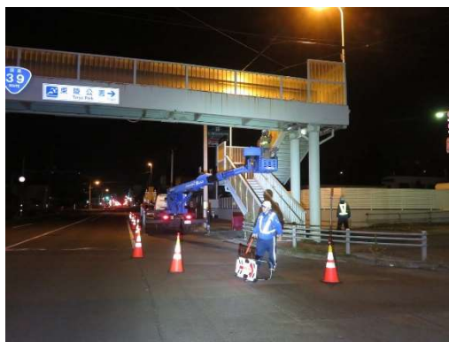
【横断歩道橋点検】
