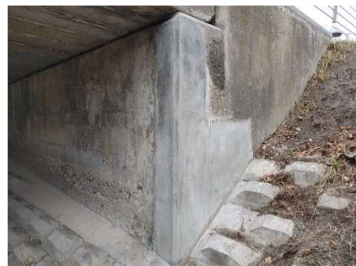
【橋梁補修後（橋台）】
