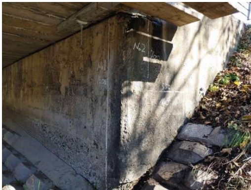
【橋梁補修前（橋台）】
