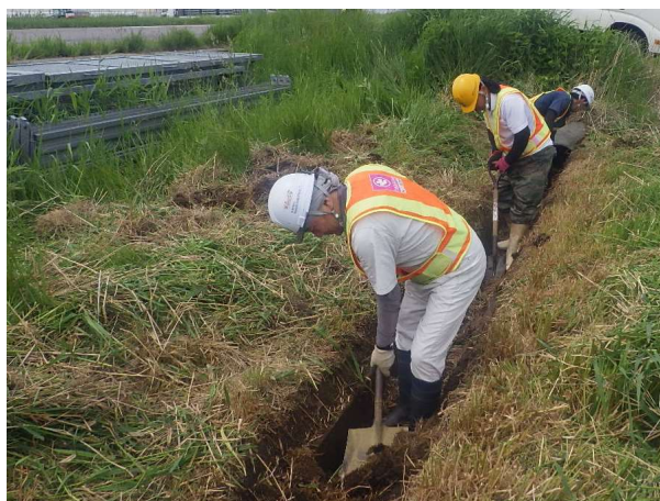
【排水構造物清掃】
