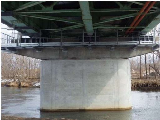
【耐震補強（下部工補強）】
