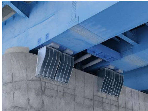
【耐震補強（落橋防止工）】
