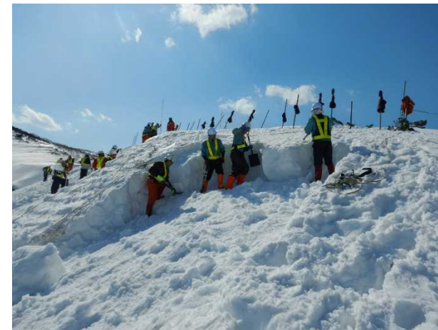
人力による雪庇処理、斜面除雪
