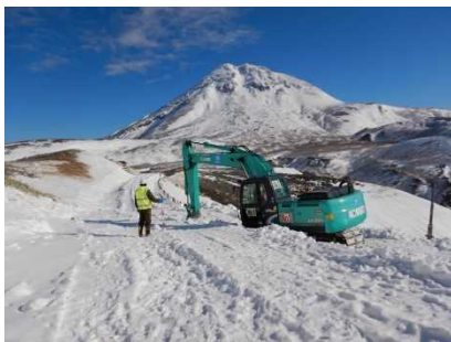
油圧ショベルによる作業状況
