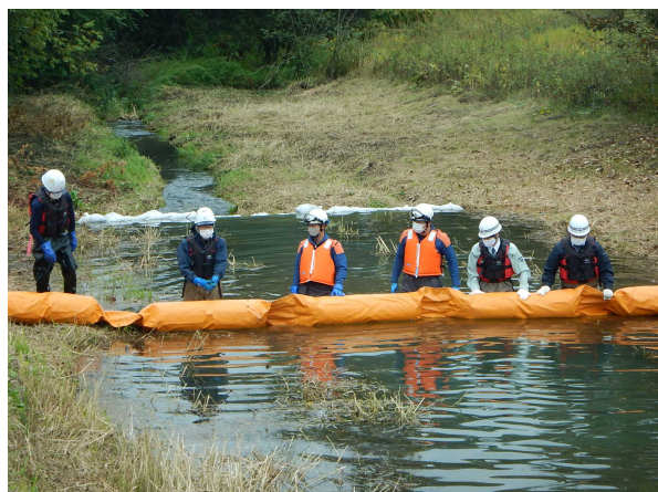
現地対策訓練（オイルフェンス設置）
