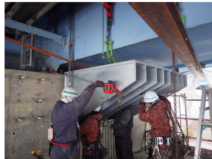
緊急輸送道路上の橋梁の耐震補強 (美幌町 国道39号)
