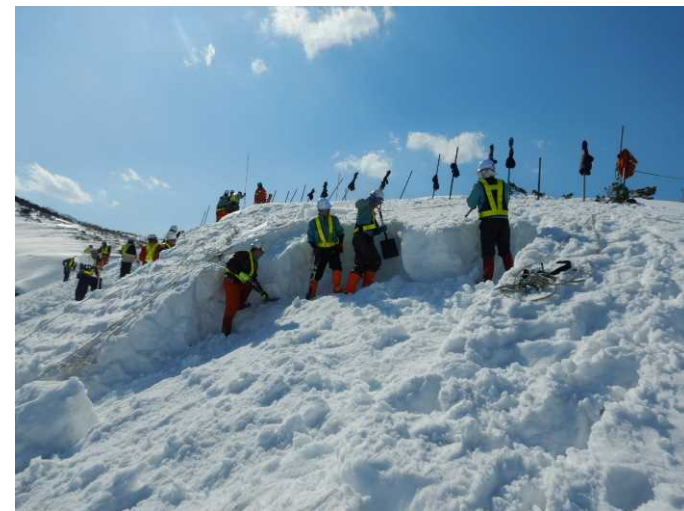
人力による雪庇処理、斜面除雪
