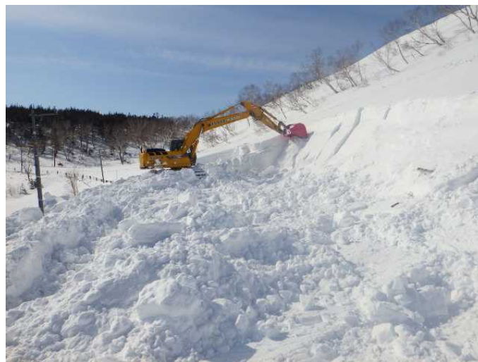
油圧ショベルによる斜面除雪
