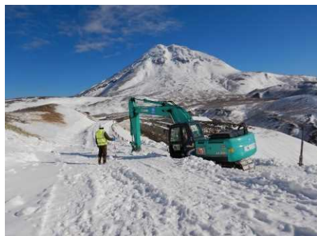
油圧ショベルによる作業状況
