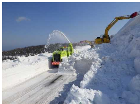
ロータリ除雪車による作業状況
