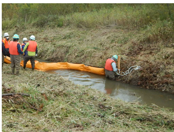
現地対策訓練（オイルフェンス設置）
