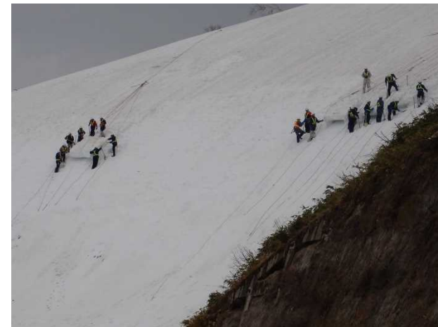
人力による雪庇処理、斜面除雪
