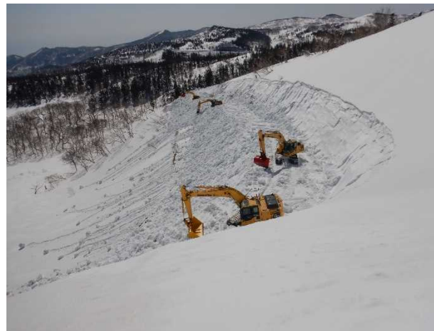
油圧ショベルによる斜面除雪
