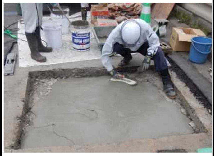
作業完了写真(床版補修完了)
