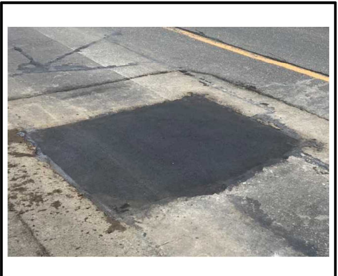
作業完了写真(床版補修完了)
