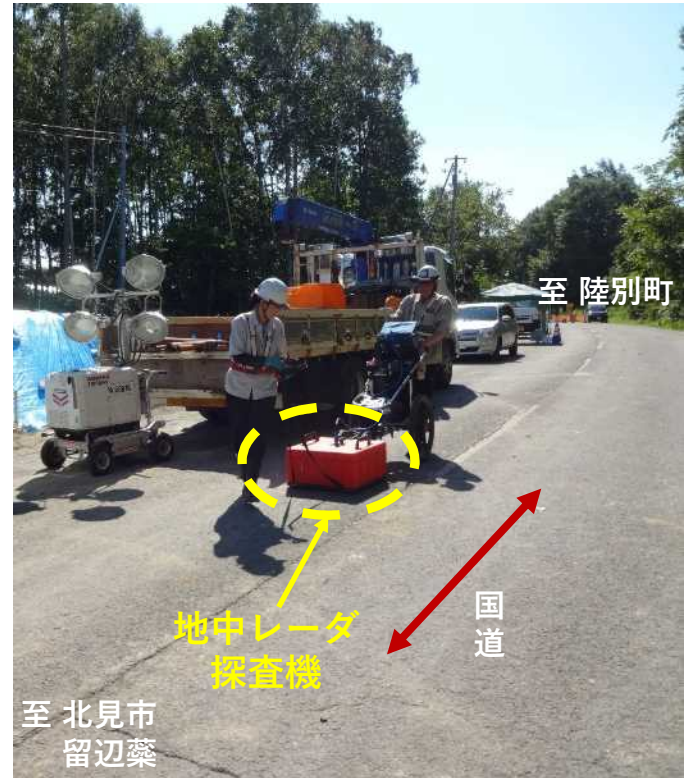
△8月31日(木) 地中レーダー探査状況
