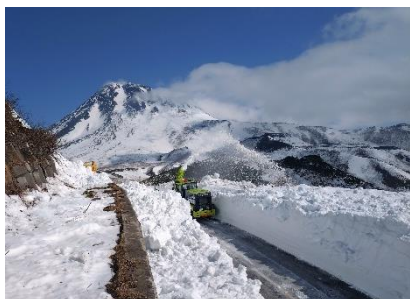
ロータリ除雪車による作業状況
