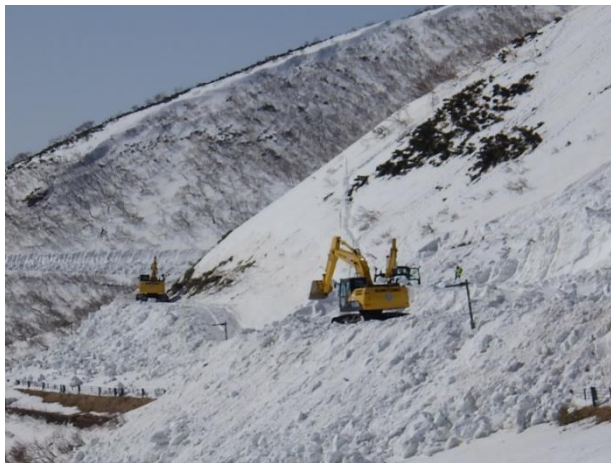
油圧ショベルによる斜面除雪
