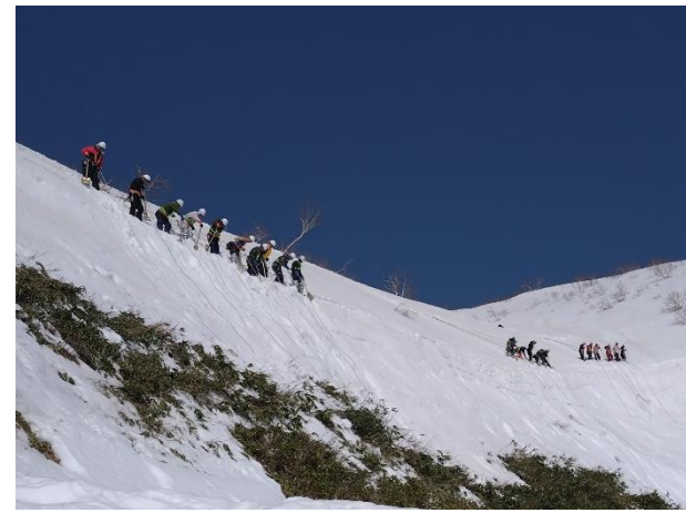
人力による雪庇処理、斜面除雪
