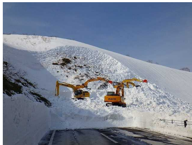
複数の機械による斜面除雪
