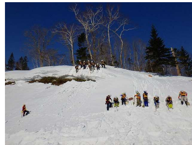
人力による雪庇処理、斜面除雪
