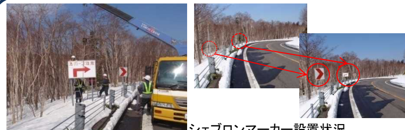
シェブロンマーカ―設置状況
