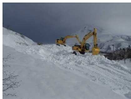
油圧ショベルによる作業状況
