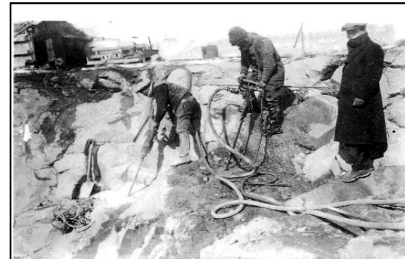
人力での 岩盤掘削 状況
