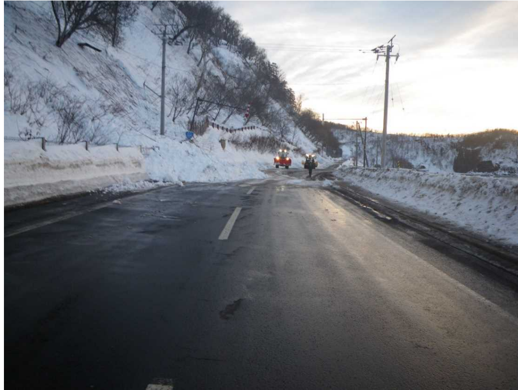
雪崩発生箇所法面状況
