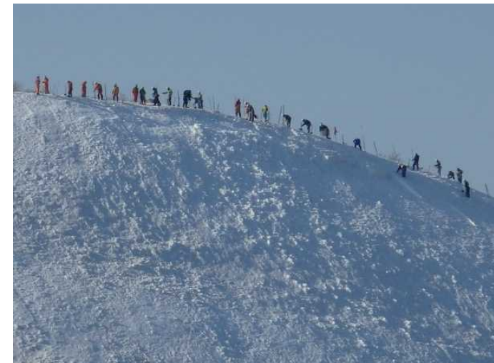
人力による雪庇処理、斜面除雪
