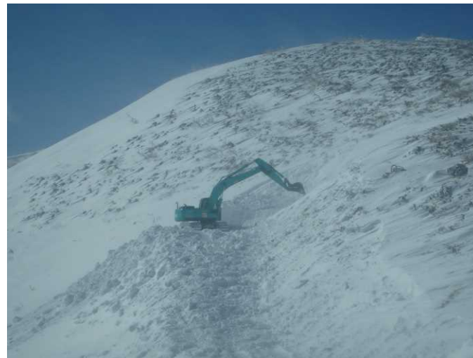
油圧ショベルによる斜面除雪
