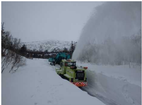
ロータリ除雪車による作業状況
