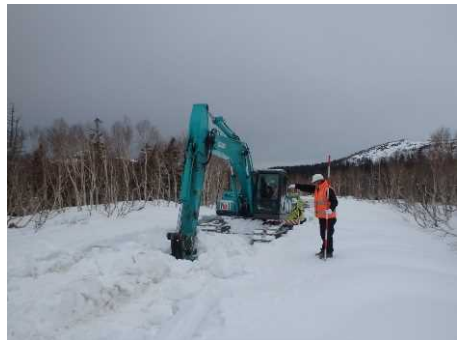
油圧ショベルによる作業状況
