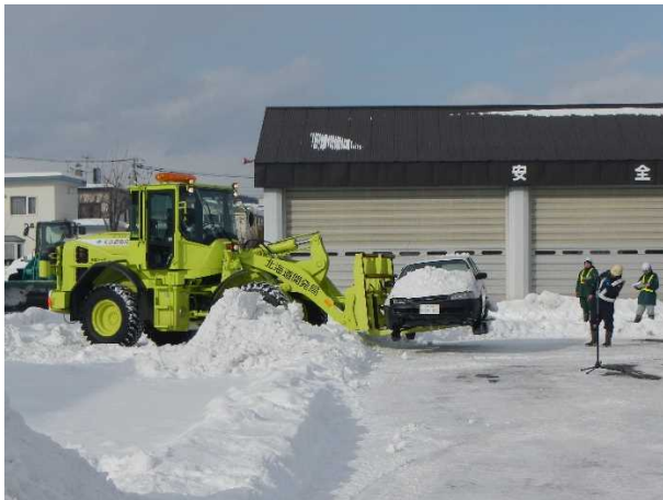
①道路啓開
