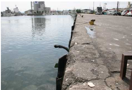
岸壁の老朽化状況
