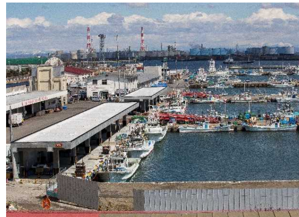
屋根付き岸壁の暫定供用状況 (苫小牧港西港区汐見地区)
