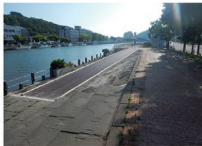
河川管理用道路（整備後）
