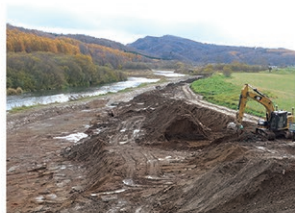
河道掘削状況（常呂川）
