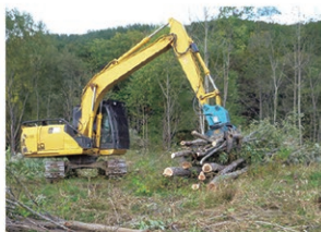
樹木伐採状況（渚滑川）
