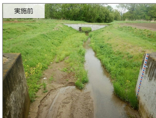
堤外排水路の土砂撤去（川向8号樋門）
