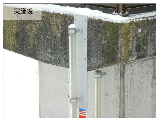
洪水痕跡計設置板の修繕（中里樋門）
