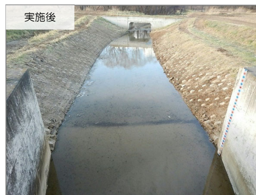
堤外排水路の土砂撤去（川向8号樋門）
