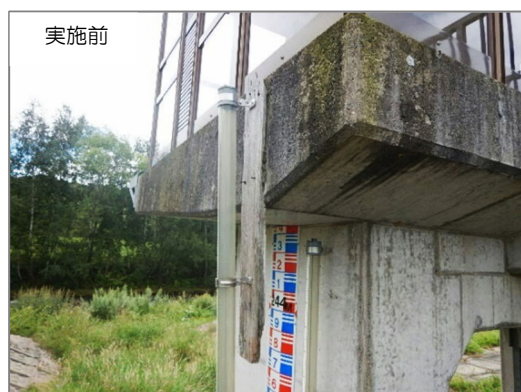
洪水痕跡計設置板の修繕（中里樋門）
