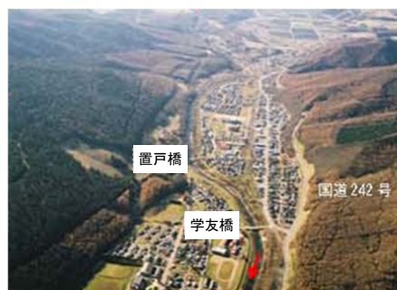
常呂川 上流部
