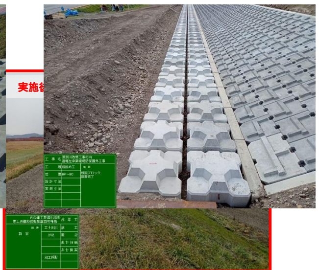
法面補修の実施状況
