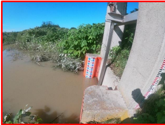
樋門水路から河道状況
