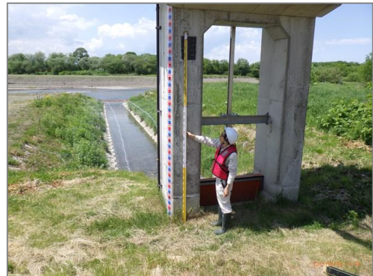
管理施設点検の実施状況
