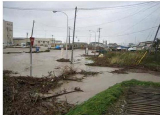
平成 18 年 10 月洪水の状況 （湧別町河口漁港の被災状況）
