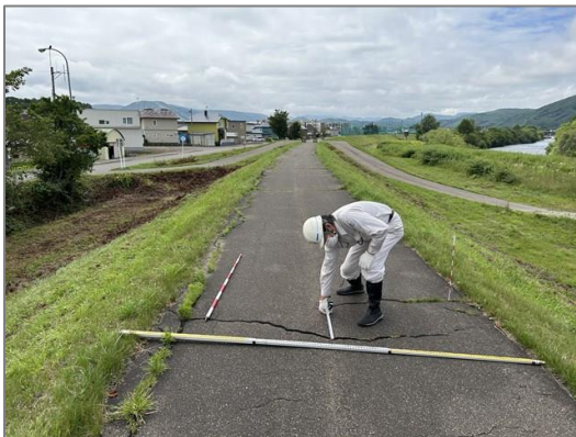
堤防点検の実施状況
