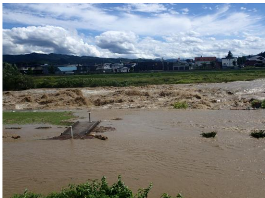
平成 28 年 8 月洪水の状況 (遠軽町大通南の三角波発生状況)
