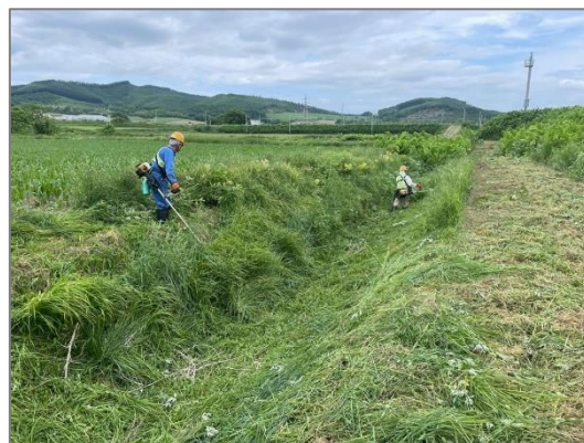
堤防除草（肩掛け式）
