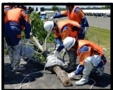
洗掘対策工法（木流し工）
