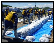
越水防止工法（積土のう工）
