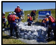
漏水対策工法（月の輪工）
