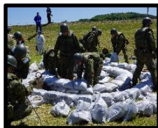
漏水対策工法（釜段工）
