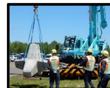
網走建設業協会等によるブロック投入工
