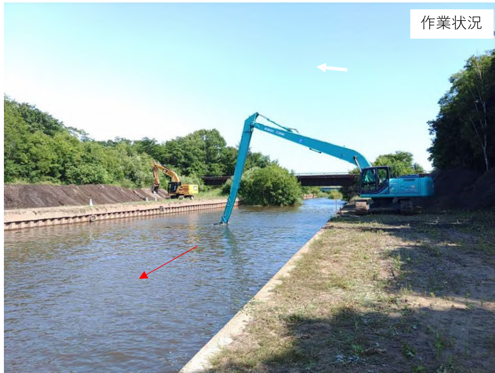
河道掘削（女満別川）
