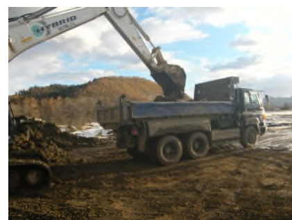
ダンプトラックへ積み込み、
