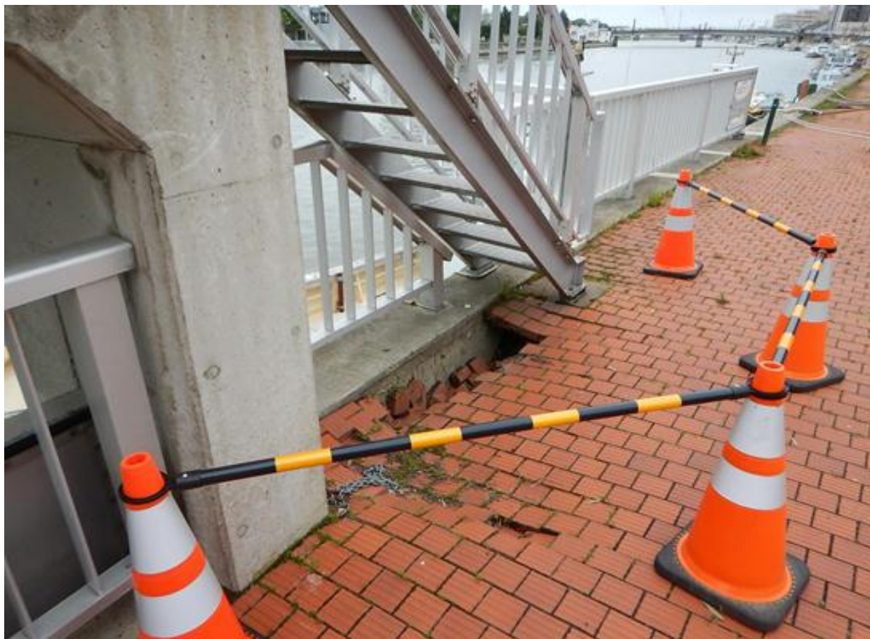
○写真② 白鳥樋門(中央橋上流右岸):インターロッキング舗装の沈下有り
