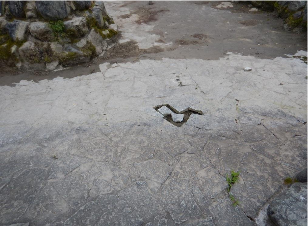
○写真① 遠軽橋付近左岸:せせらぎ広場の水路において河床ブロック損傷有り
